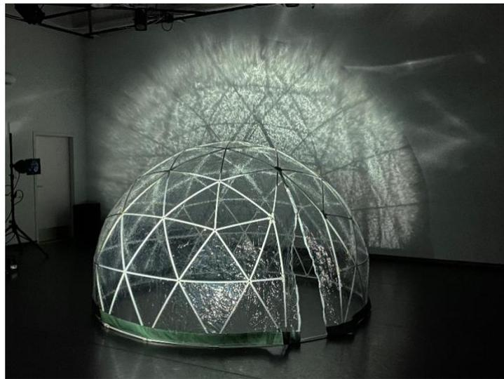
La demi-sphère, géodésique, montée sur place en pièces détachées, est posée au sol, au milieu du plateau, 2,85 m de diamètre. 1, 80 m de hauteur
